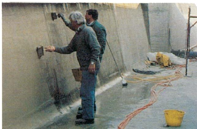
*Imperméabilisation d'un canal avec ANTOL AQUAPROOF mélangé avec NEOPLAST LATEX*
