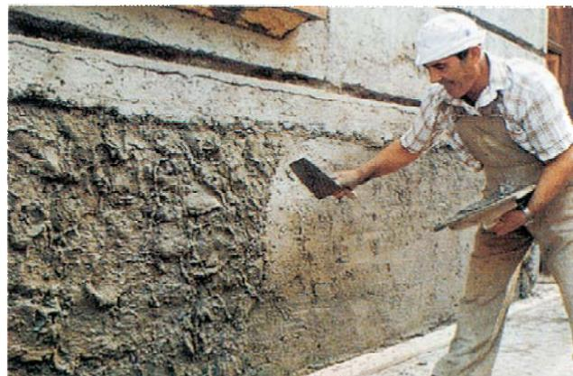
Régularisation d'un support de maçonnerie avec mortier mélangé avec **NEOPLAST LATEX**
