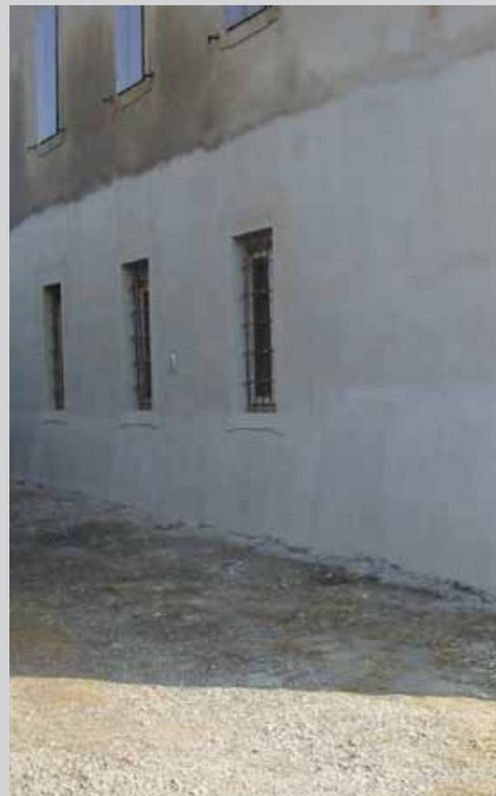
Le lissage doit durcir pendant au moins 21 jours, après quoi, si c'est nécessaire, il peut être peint avec de l'ANTOL RISAN SYSTEM PITTURA ou avec d'autres peintures siloxanes, aux silicates ou à la chaux, pourvu qu'elles soient fortement respirantes. Il est possible de nettoyer les outils de pose avec de l'eau avant le durcissement du mortier ; par la suite, le nettoyage ne peut se faire que de façon mécanique.
