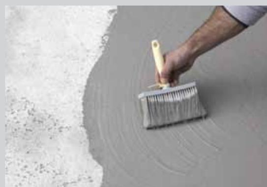
épaisseur totale de 2 mm, en laissant s'écouler une durée suffisante d'une couche à l'autre pour permettre le durcissement de la dernière couche appliquée (4 à 6 heures environ à 20°C).
