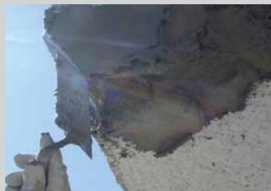
complètement durci, appliquer manuellement le mélange d'**ANTOL CLS SYSTEM RESTAURO** à l'aide d'une truelle ou d'une spatule américaine ou bien par projection à l'aide d'une machine à enduire appropriée (la prise étant particulièrement rapide, toujours nettoyer les tuyaux et la lance de la machine à enduire toutes les fois que l'on prévoit un arrêt de travail afin d'éviter toute obstruction difficile à éliminer).
